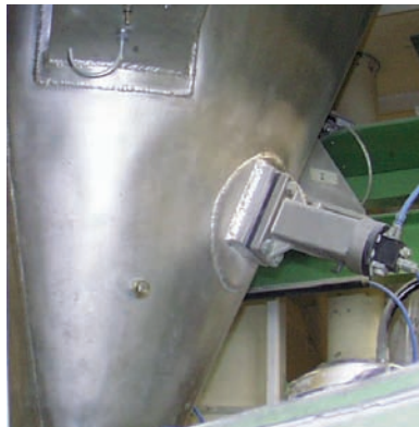
Abreinigen von Bunkerwänden
